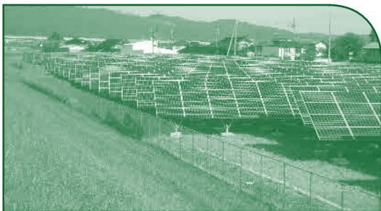
Shima Project : Toyama, Japan 1.25 MW COD : 1 March, 2016
