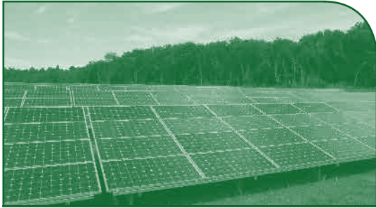
Kuno Project : Ibaraki, Japan 0.5 MW COD : 18 August, 2015
