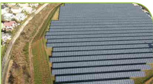
Ryugasaki Project : Ibaraki, Japan 1.99 MW COD : 1 September, 2016
