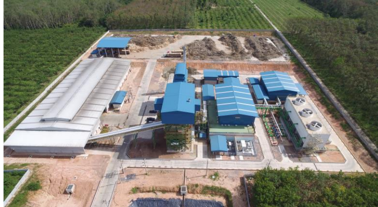
รูปที่ 3 โรงไฟฟ้าชีวมวล “ออสการ์โครงการ 2” ขนาดกำลังการผลิตเสนอขาย 8.8 เมกะวัตต์ จังหวัดนครศรีธรรมราช (COD ตุลาคม 2561)
